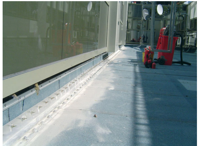
Bild 3. Dehnfuge mit Los-/Festflansch und Abdeckblechen als mechanischer Schutz des Fugenbandes (Fotos: Hamed El Diwany)
