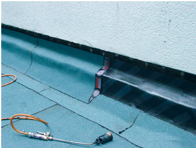
Bild 2. Sanierung: handwerklich saubere Leistung am Abdichtungsanschluß
